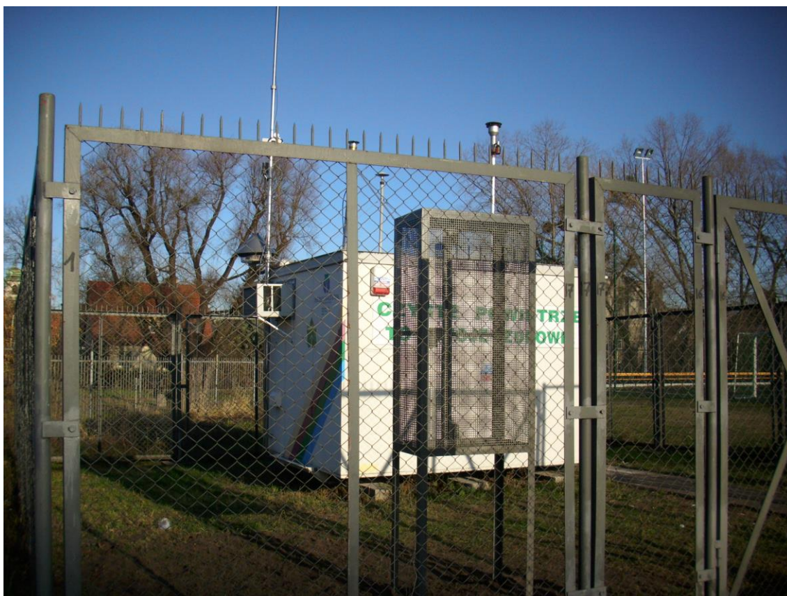
Ryc.5. Przykładowe zdjęcie stacji referencyjnej Fundacji ARMAG.
